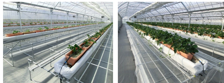
温室内設備に関する施工も全て行います。
